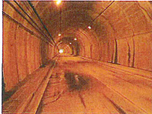
トンネル内状況
