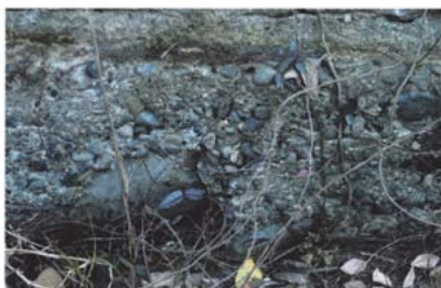
写真 1 基礎コンクリート
