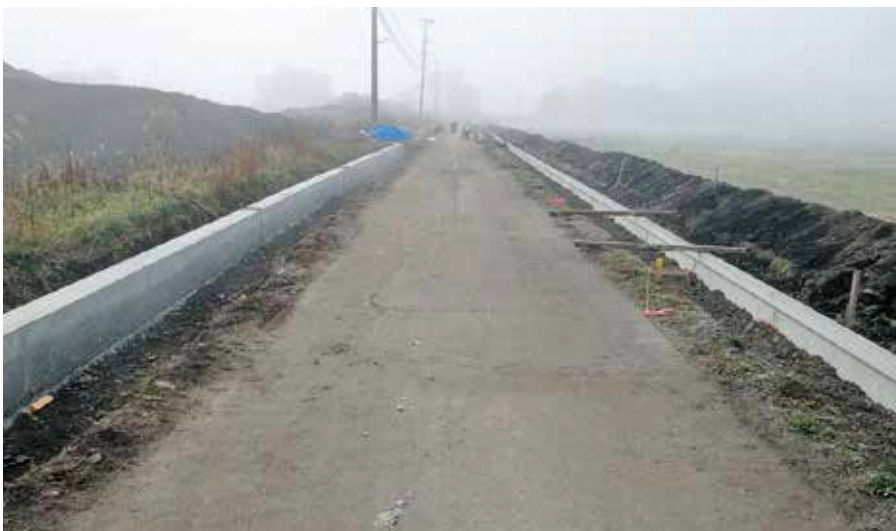
改良中の村道
