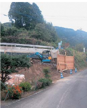
県道相良人吉線道路改良工事状況
