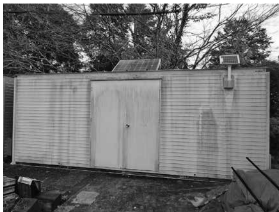
役場下の駐車場に設置されている防災倉庫
