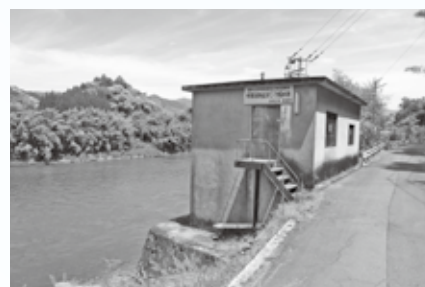
棚葉瀬ポンプ用水路（取入口）
