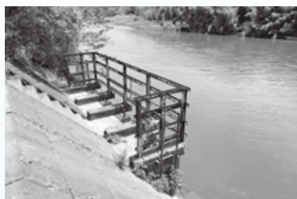
柳瀬西溝用水路（取入口）
