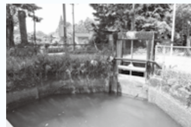
飛行場用水路の六角水路
