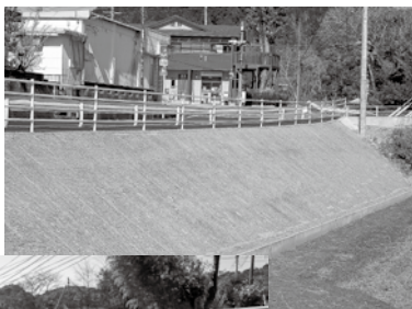
1工区 土羽法面
