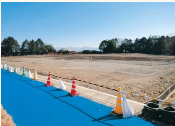
運動公園ヘリポート舗装工事
