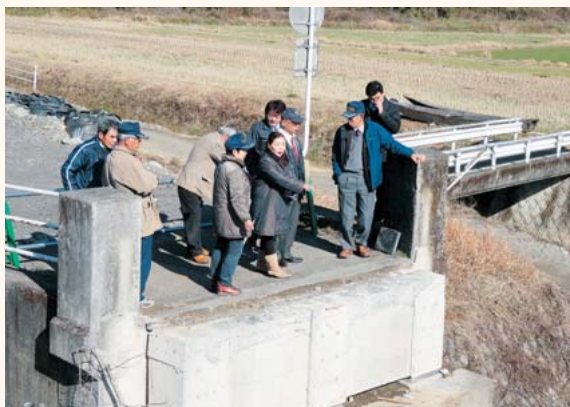
村道廻谷線道路改良事業護岸工事
