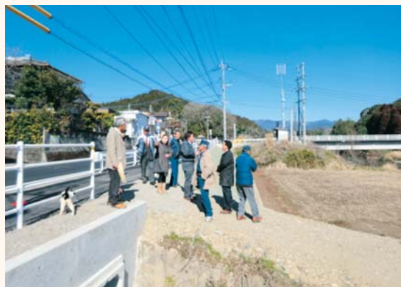
村道平原十島線歩道拡幅工事
