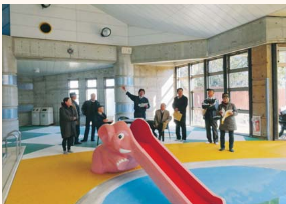
リフレッシュビレッジ施設整備事業 (茶湯里プール棟天井改修工事等)
