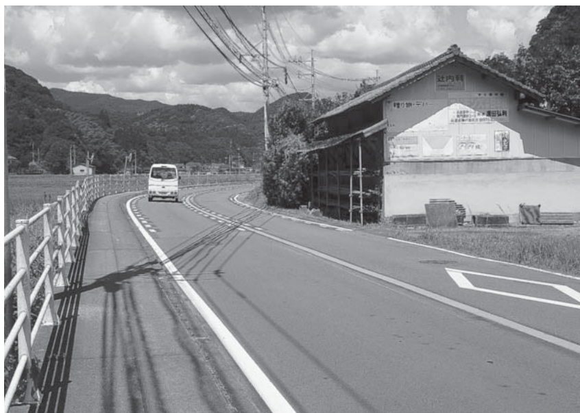
雨宮地区(国道445号)
