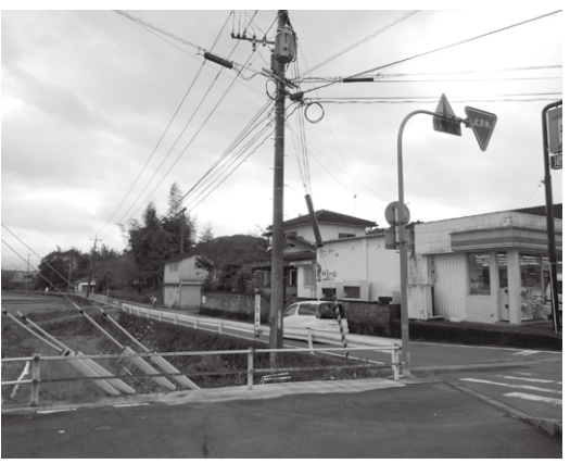
改良が先延ばされた村道平原十島線(柳瀬橋側)
