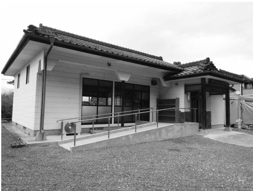
国県の補助事業で改修された集会施設(境田地区)
