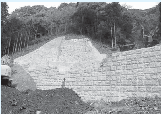
災害復旧工事現場
