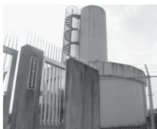
柳瀬地区簡易水道施設
