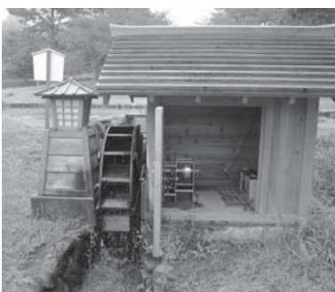
あさぎり町ビハ公園内の水車による小力発電 （昨年の議員研修にて撮影）
