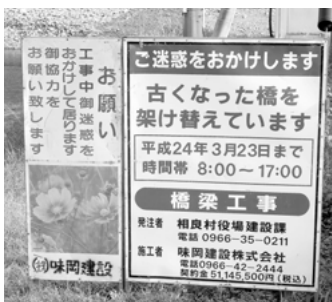
廻橋の工事標識
