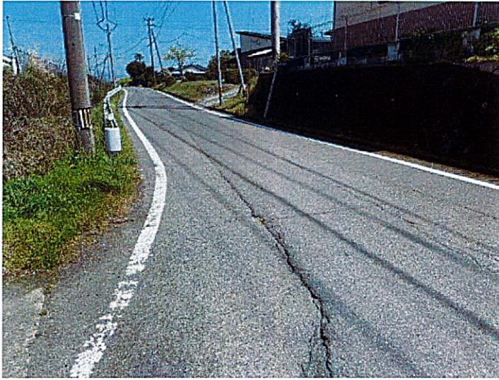
18 新並木 歩道が狭く危険（増田電設付近） （対策）新設の道路改良の予定があるため、直近での対応が難しい
