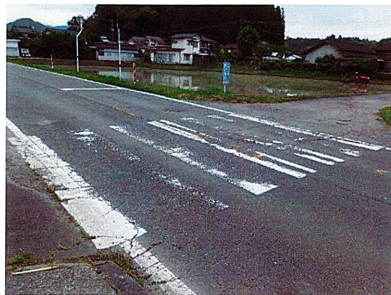
1 2 雨宮神社周辺 横断歩道の線が薄くなっている (対策) 舗装要望箇所として上申、対応予定
