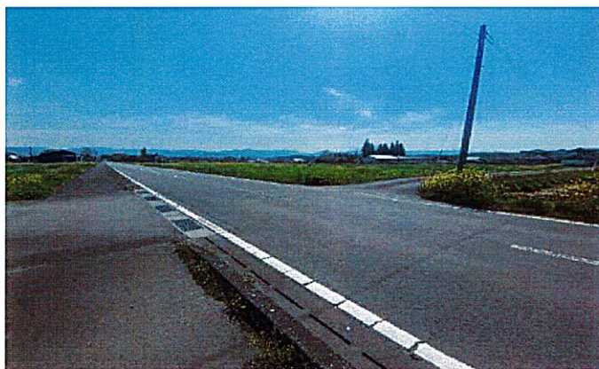
15 生田鉄工所へ向かう道路 白線が薄くなっている (対策) 舗装改修の予定あり
