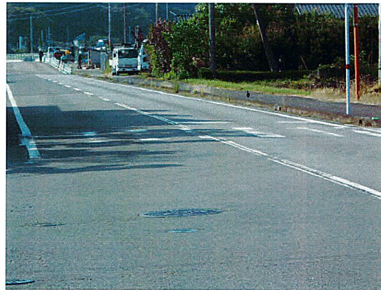
19 蓑毛観音バス停付近 横断歩道の白線が消えかかっている（2カ所） （対策）補修箇所として上申済み、令和8年度に補修予定
