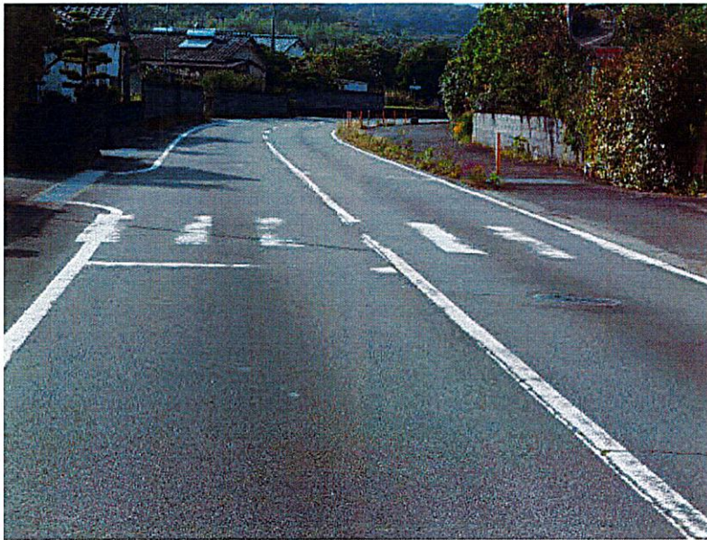
19 蓑毛観音バス停付近 横断歩道の白線が消えかかっている（2カ所） （対策）補修箇所として上申済み、令和8年度に補修予定
