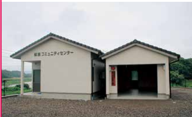
完成した柳瀬コミュニティセンター
